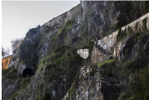
Ramal está desactivado desde 1989 ADRIANO MIRANDA
