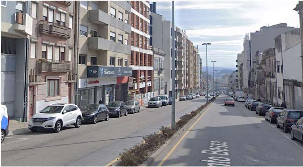
Rua de Pinto Bessa | Existente
