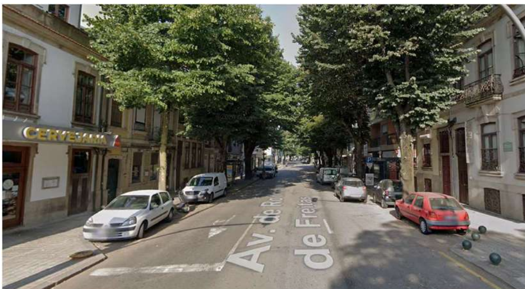
Av. Rodrigues de Freitas | Existente
