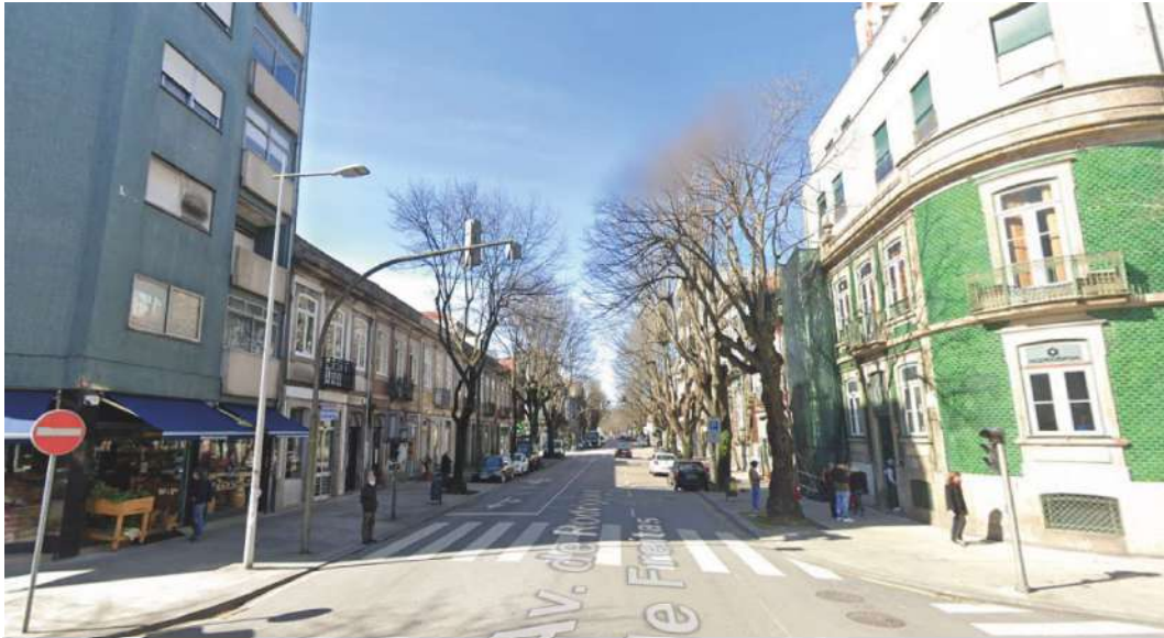
Av. Rodrigues de Freitas | Existente
