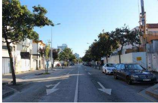
Figura 103 - Exemplo de uma rua adequadamente arborizada: rua média com árvore de copa média ( Acer pseudoplatanus na Avenida da França).
